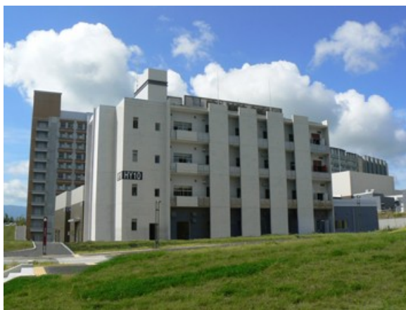
水素実験専用施設
