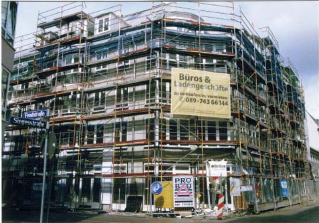
写-19 München市 Siegesstrasse の事務所建築外断熱工事(平成 14年 3月撮影)
