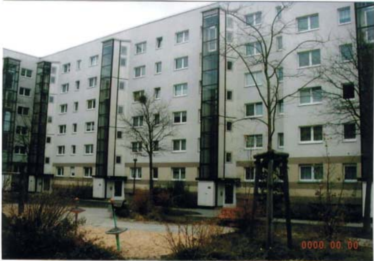
写-30 旧東ベルリン地区 Hellersdorf における集合住宅の外断熱改修工事(平成 14 年 11 月撮影)
