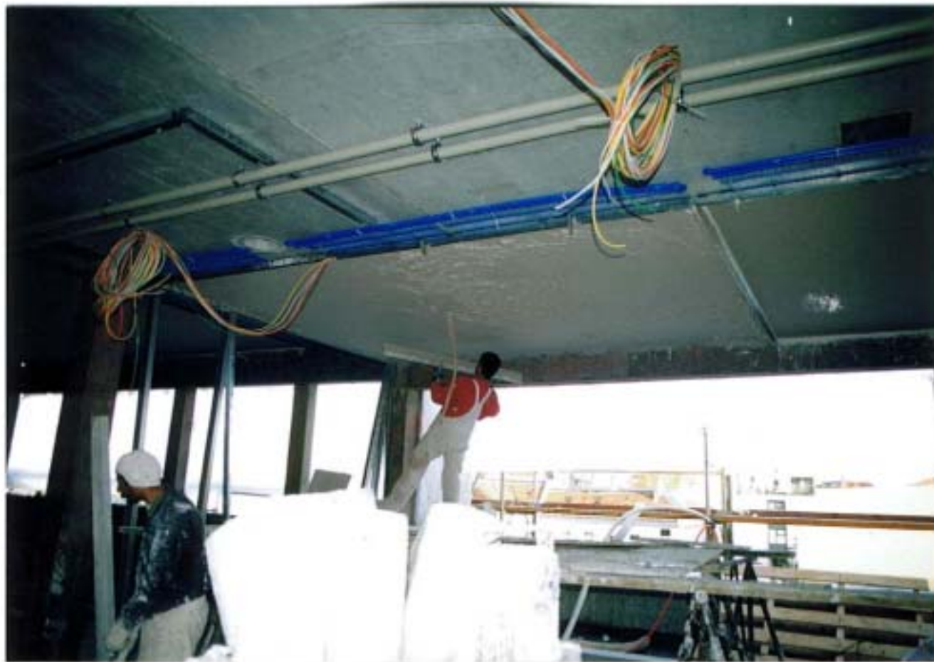
写-38 Berlin市 Steglitzの事務所建築における天井放射冷暖房工事(接着モルタルを用いてポリプロピレン配管を天井に埋設)
