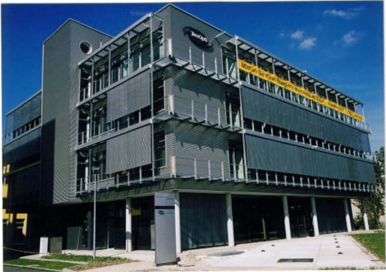
写-35 München市Frankfurterringの事務所建築外断熱工事竣工写真(平成14年8月撮影)
