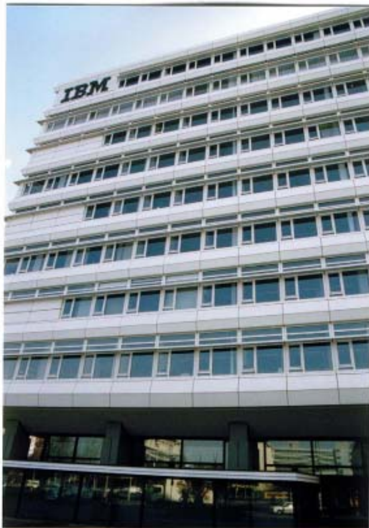
写-23 Berlin市 Ernst ReuterplatzのIBMビル外断熱工事竣工写真、平成14年3月撮
