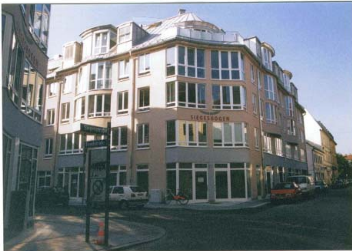
写-20 München市 Siegesstrasseの事務所建築外断熱工事竣工写真(平成14年8月撮影)
