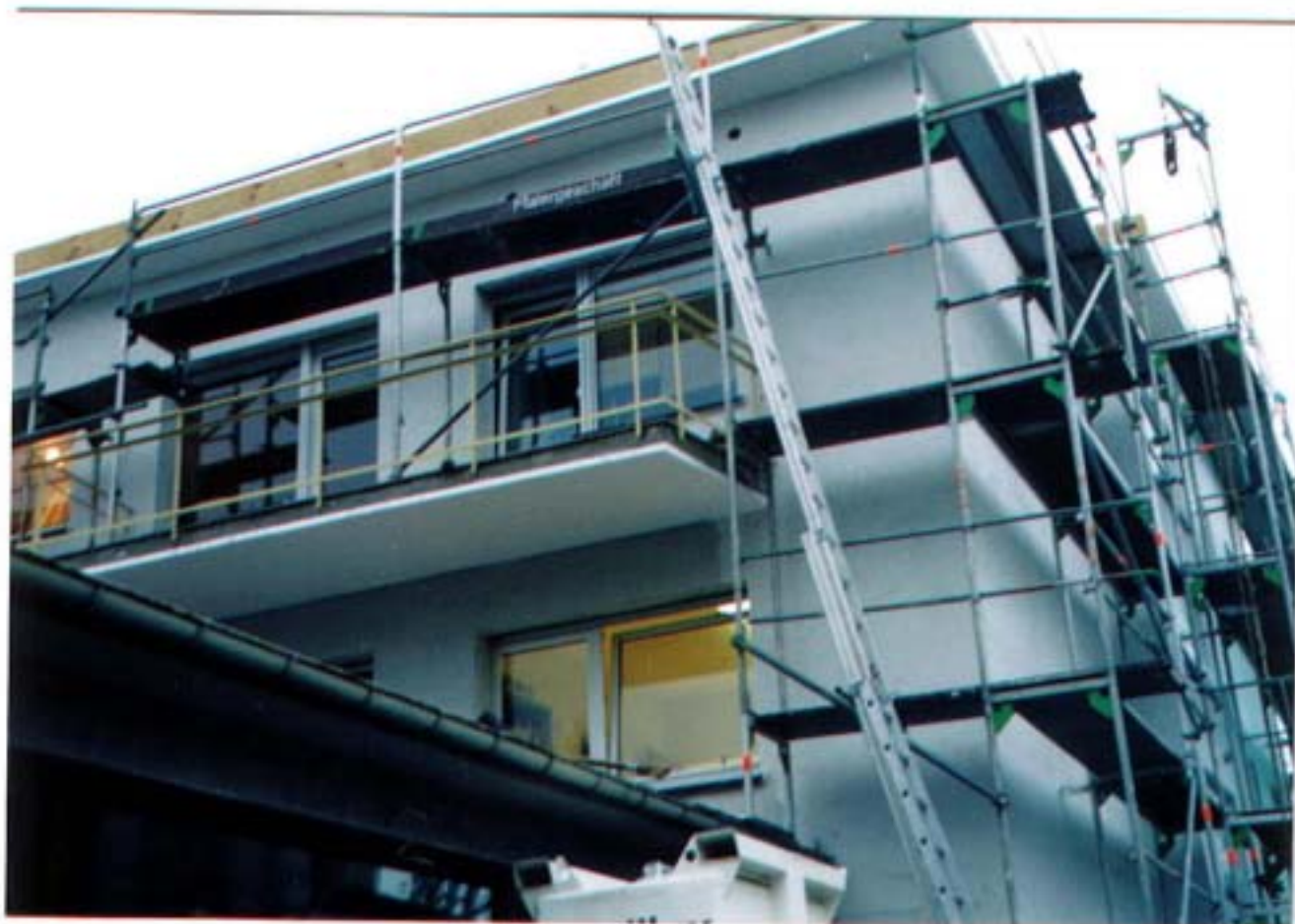
写-13 Stuttgart市Wellgrebenの塗装業者ビルの外断熱改修(平成13年10月撮影)
