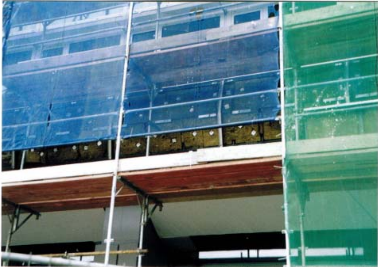
写-21 Berlin市 Ernst Reuterplatz の IBM ビル外断熱工事(平成 13 年 10 月撮影)
