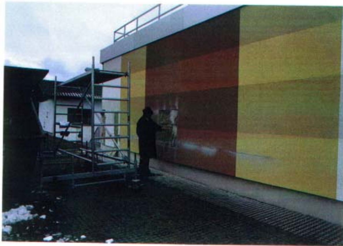
写-4 外断熱工事の耐性試験の説明をする Gertis 教授 (Holzkirchen の Fraunhofer 研究所) (平成 13 年 10 月撮影)
