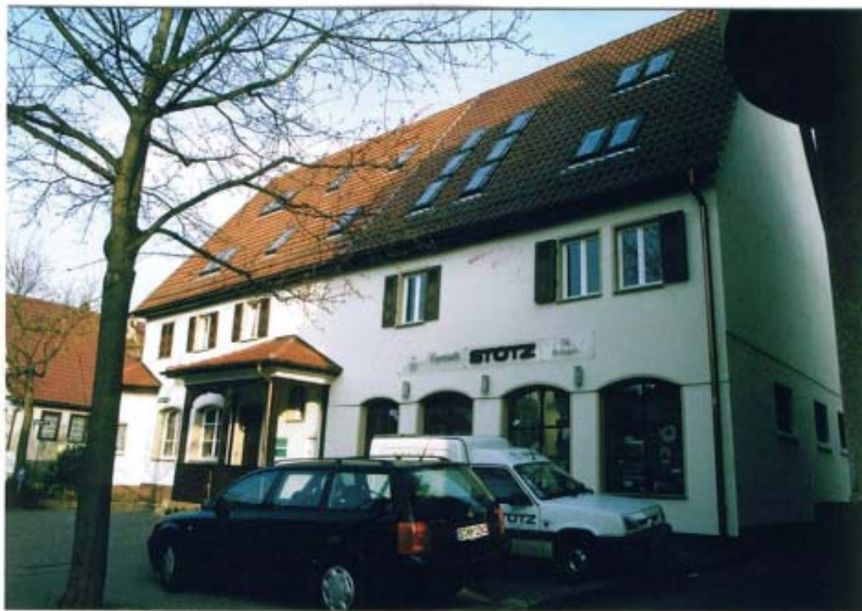
写-11 Stuttgart市 Vaihingerstr. の事務所兼レストランの外断熱改修竣工写真(平成 14 年 3 月撮影)
