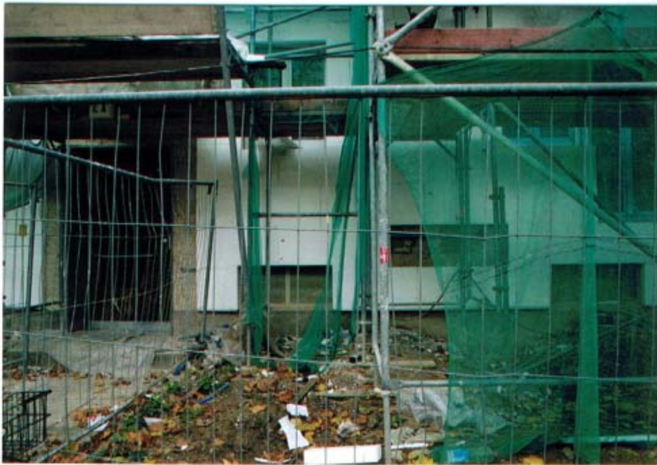
写-16 Berlin市 Heiligendammerstr.の集合 住宅外断熱改修工事(平成13年10月撮影)
