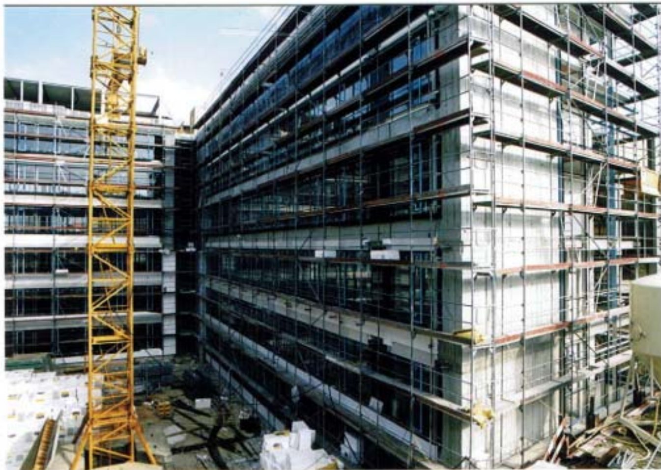
写-36 Stuttgart市 Degerlochalbstr.の事務所建築外断熱工事(平成14年3月撮影)
