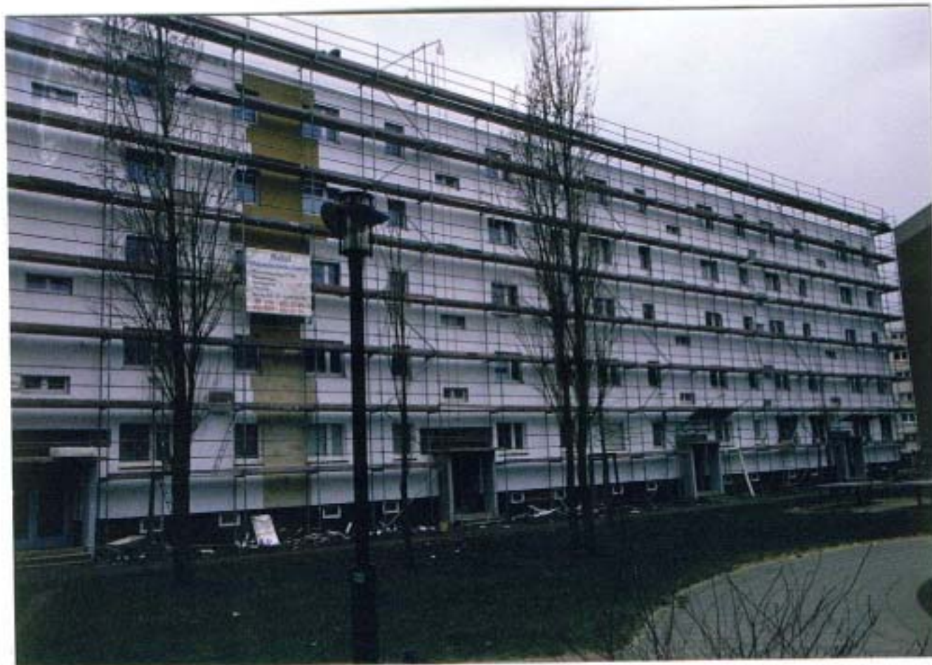
写-29 旧東ベルリン地区 Hellersdorf における集合住宅の外断熱改修工事(平成 14 年 3 月撮影)
