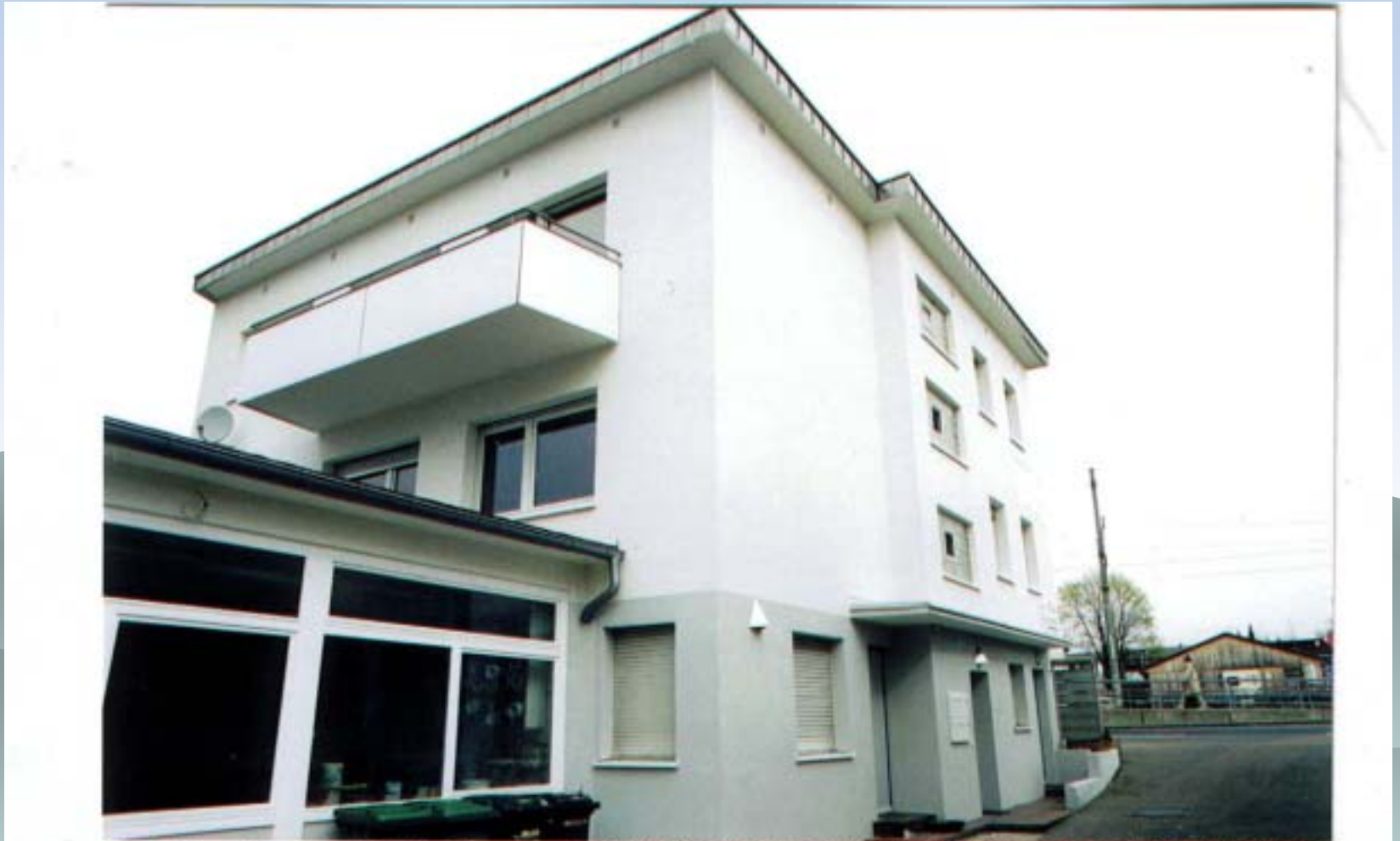
写-14 Stuttgart市 Wallgraben の塗装業者ビルの外断熱改修竣工写真(平成 14年 3月撮)
