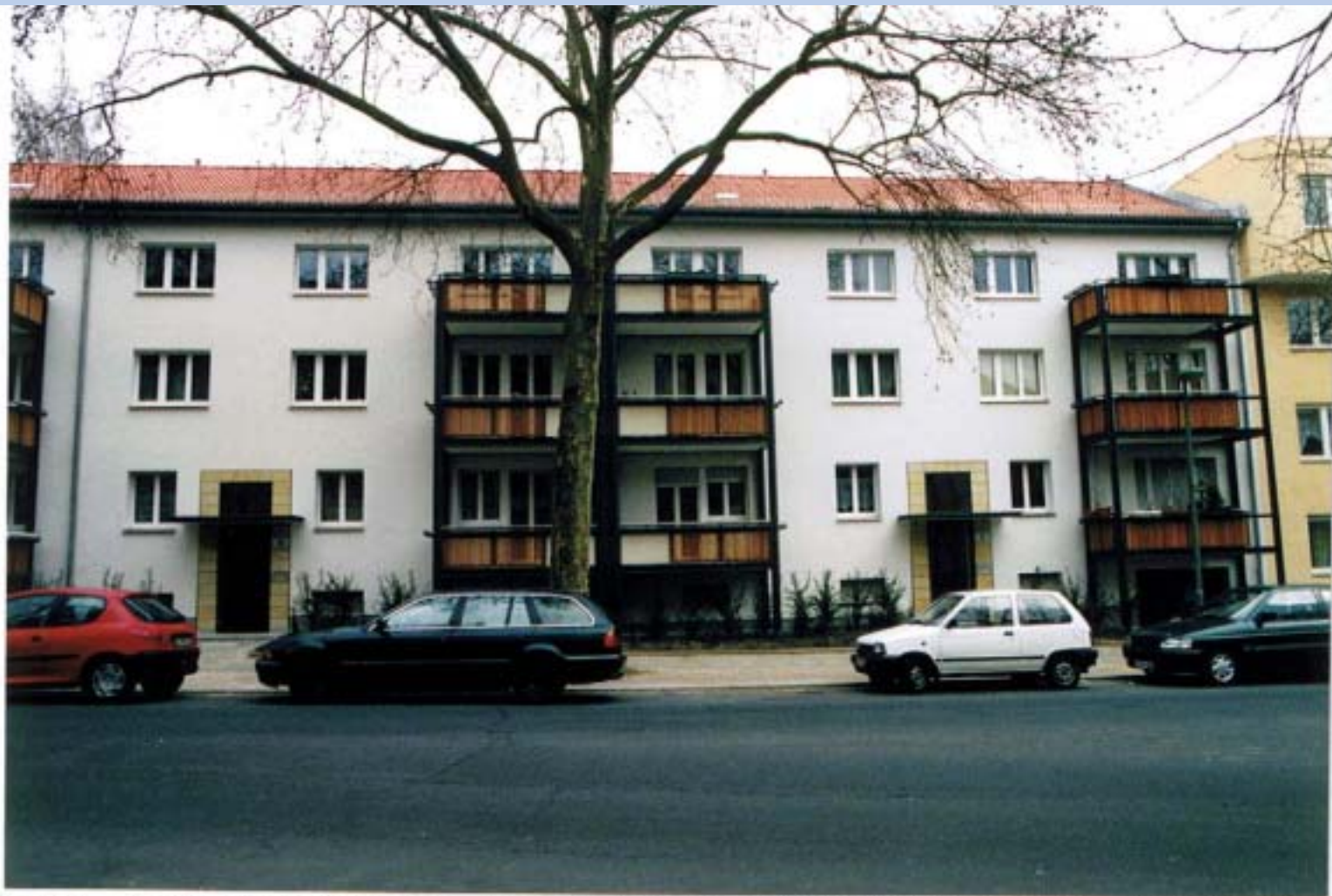
写-18 Berlin市 Heiligendammerstr.の集合住宅外断熱改修工事竣工写真(平成14年3月撮影)
