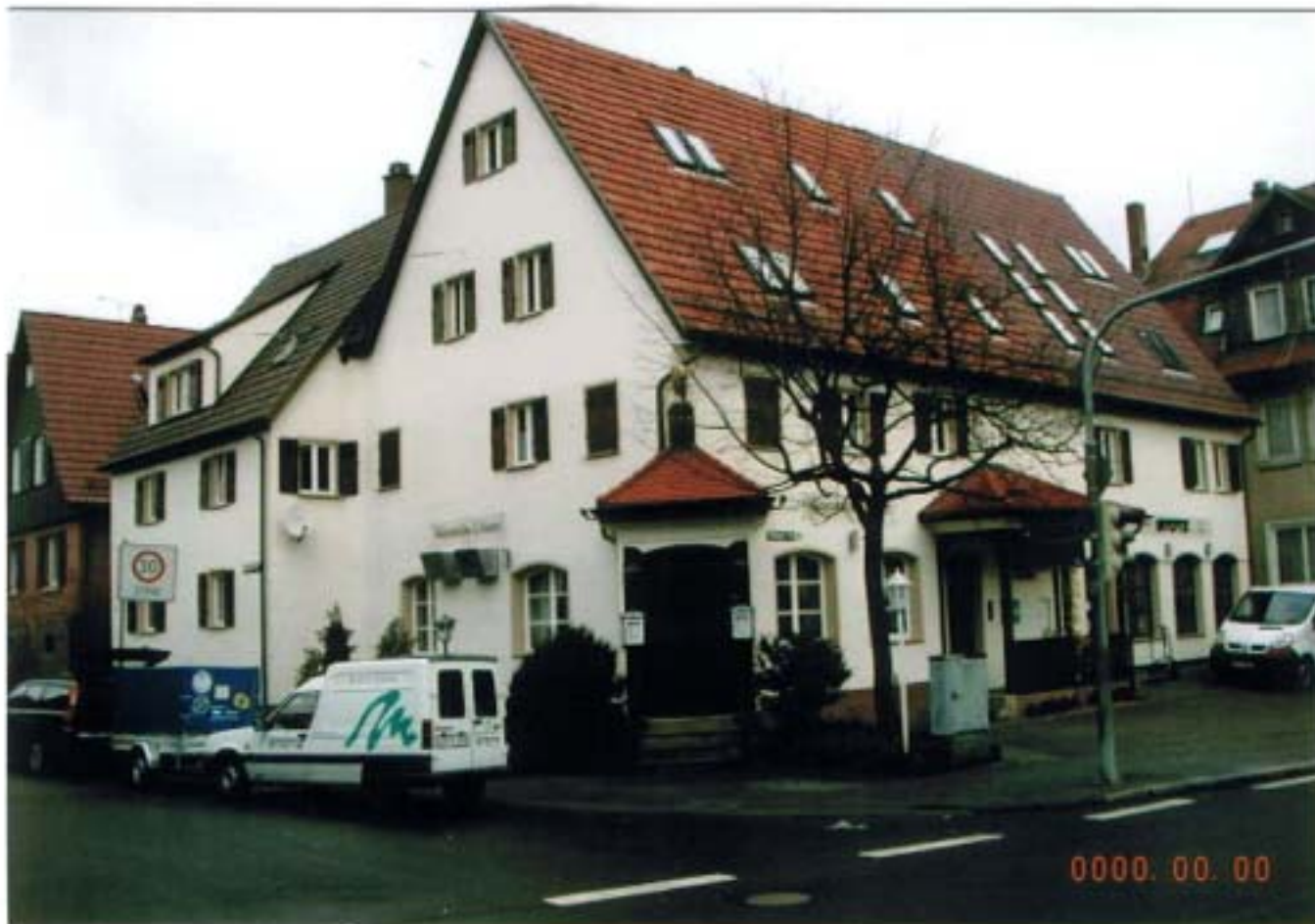
写-12 Stuttgart 市 Vaihingerstr. の事務所兼レストランの外断熱改修竣工写真(平成 14 年 3 月撮影)
