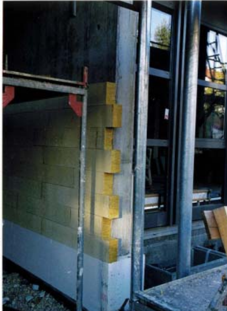
写-5 StuttgartのJurassicの事務所建築における外断熱工事 (平成13年10月)
