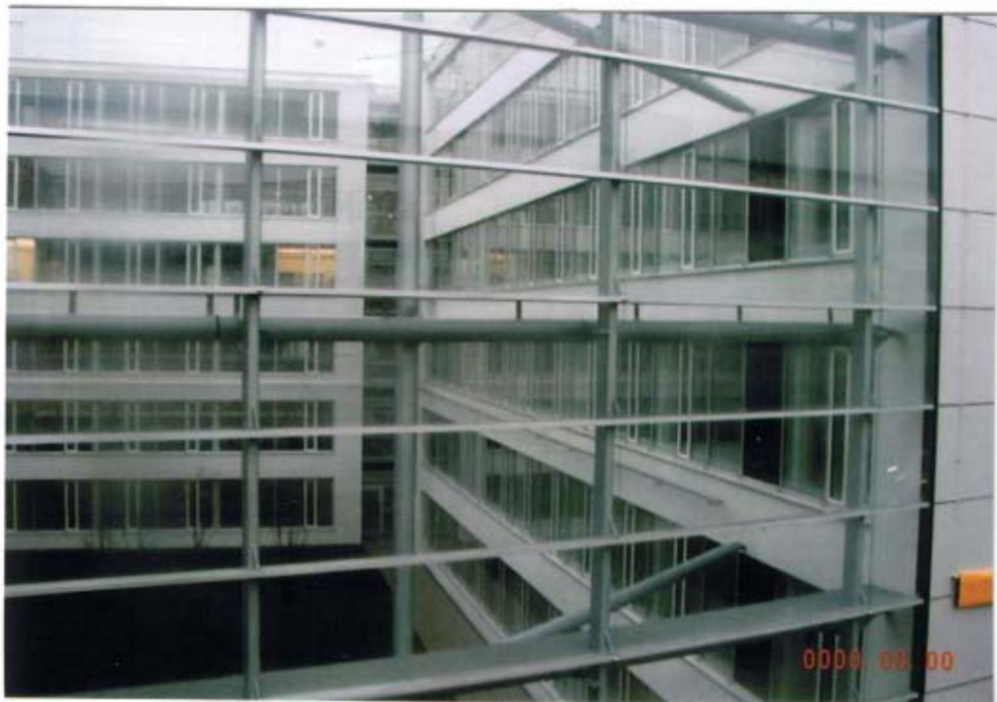
写-37 Stuttgart市 Degerlochalbstr.の事務所建築外断熱工事(平成14年3月撮影)
