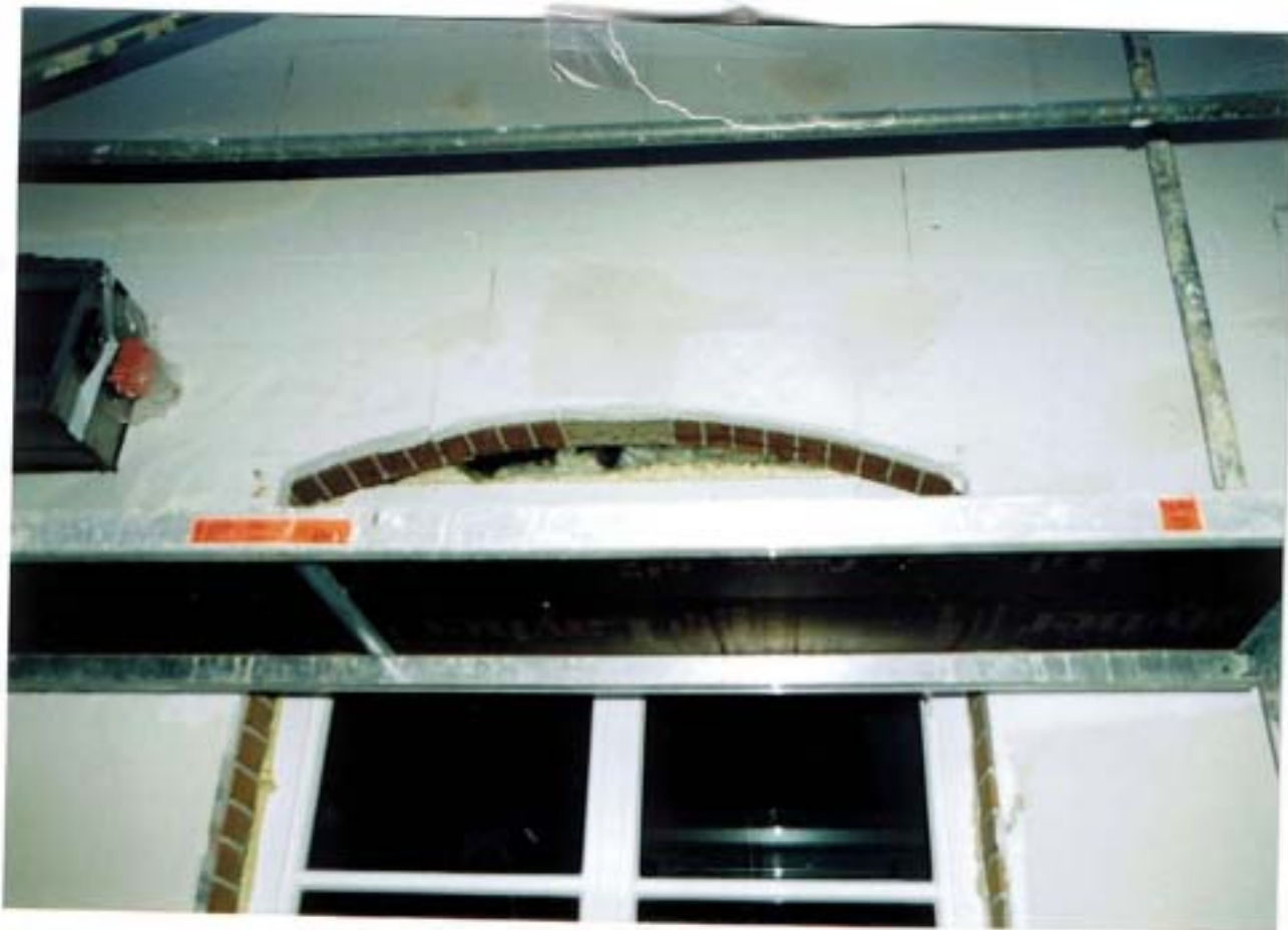
写-9 Stuttgart 市 Vaihingerstr. の事務所兼レストランの外断熱改修（平成 13 年 10 月
